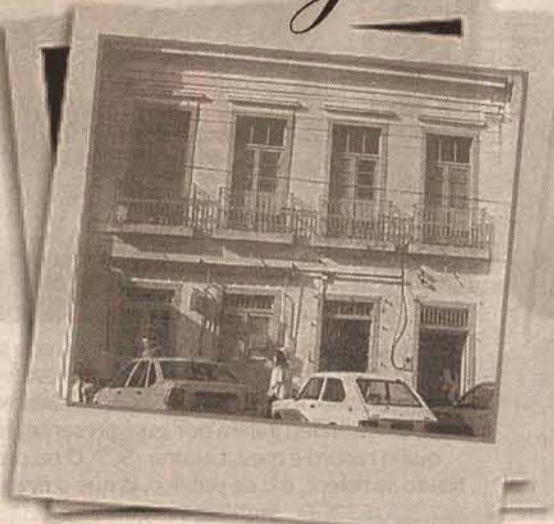
O proprietário recuperou todo o prédio, mantendo as linhas originais.
